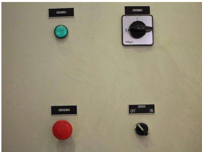
Figura 1-14. Interruptores en la parte exterior del cuadro eléctrico
