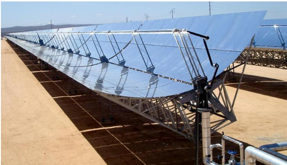
Figura 1-3 – Colector cilíndrico parabólico.
