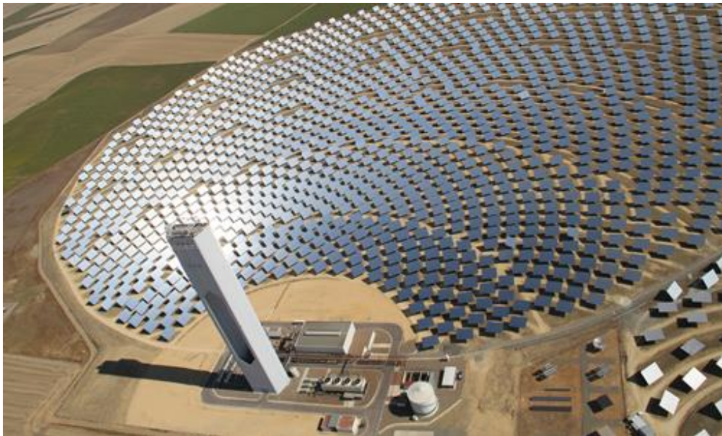
Figura 0.1: Central solar de torre
