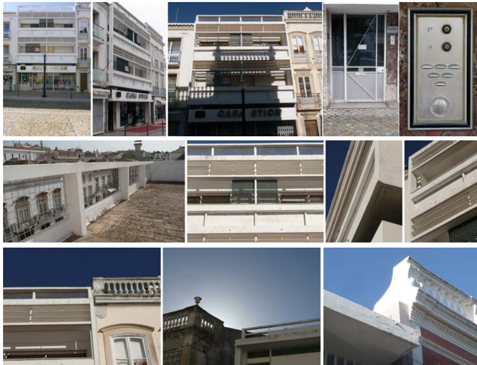
Fig. 27 y 28. MGdC, 1959. Edificio Martins Lázaro, rua da Liberdade 32.
