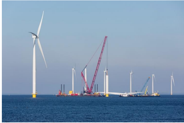
Figura 29. Instalación de energía eólica off-shore en construcción
