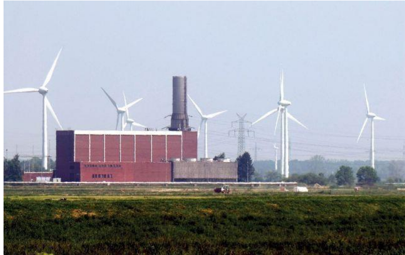
Figura 97. Instalación CAES de Huntorf
