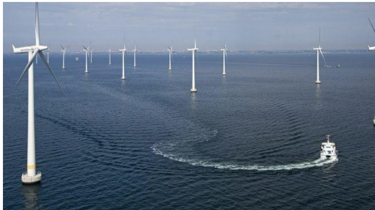
Figura 28. Instalación eólica off-shore
