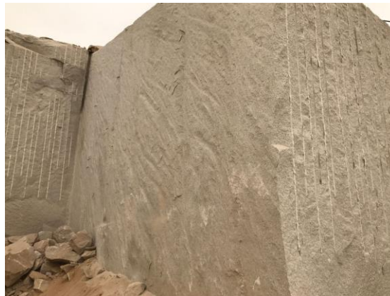
Figura 108. Excavación para HHS
