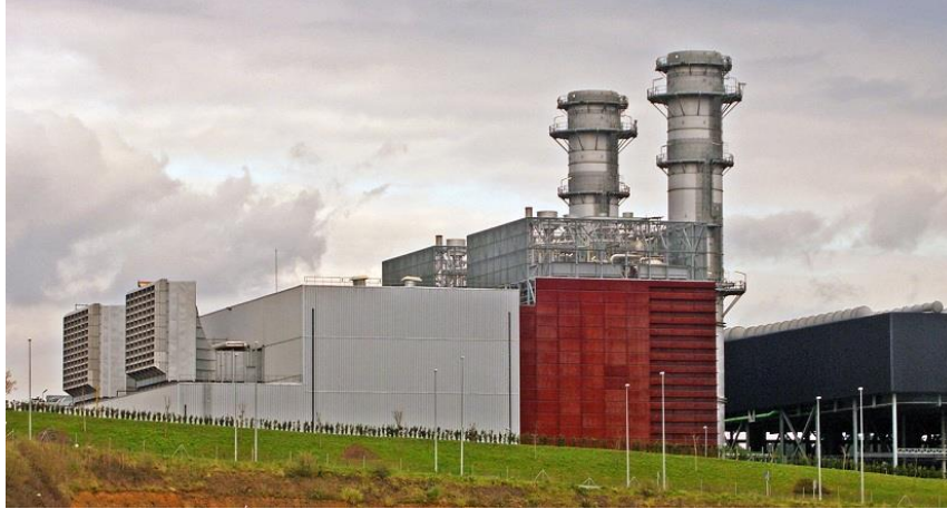
Figura 22. Planta de cogeneración mediante ciclo combinado
