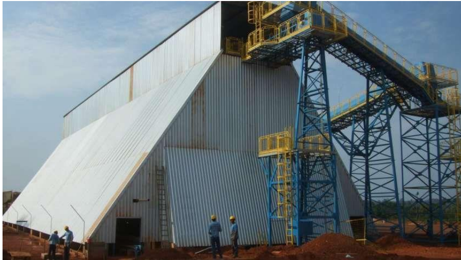
Ilustración 15: Patio de almacenamiento
