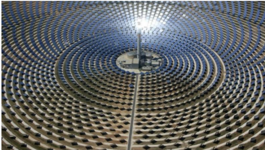
Figura 23 - Campo de heliostatos [8]
