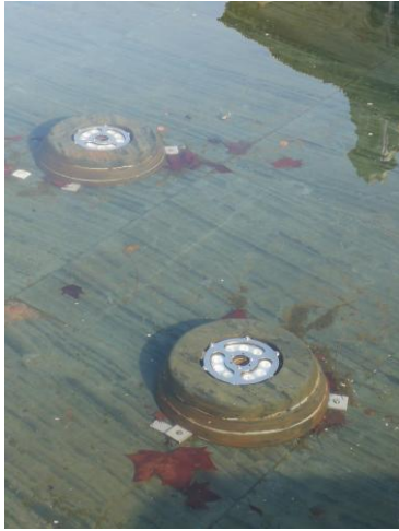
Imagen 67. Detalle lámparas LED alberca.
