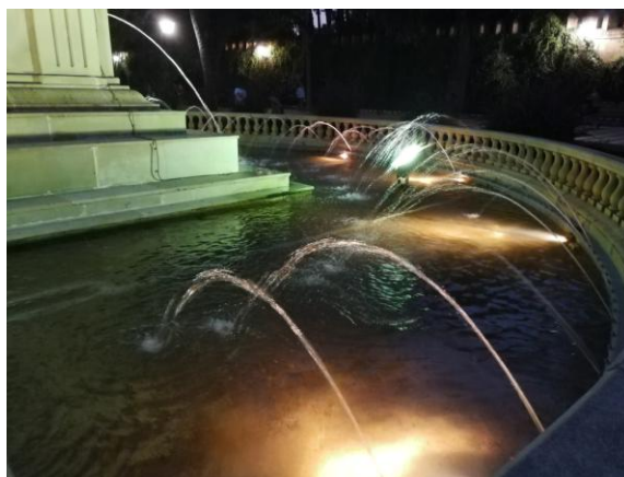
Imagen 51. Vista de la iluminación.
