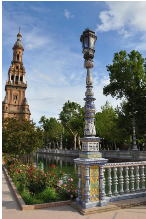
Imagen 18. Luminaria Tipo B rehabilitada.
