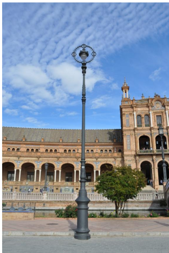
Imagen 20: Luminaria Tipo A rehabilitada.
