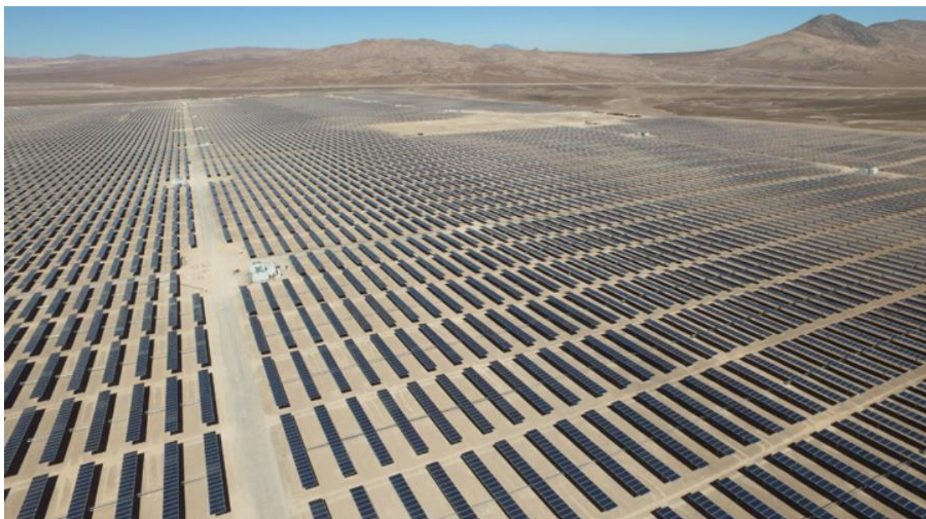
Ilustración 4: Ejemplo de planta fotovoltaica con distribución en hileras. (laderasur.com)
