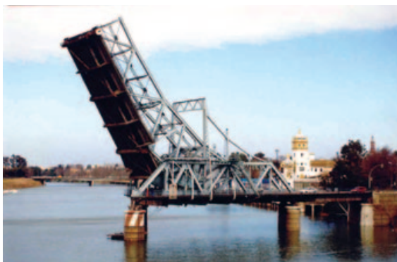
Fig. 9. Imagen del puente de Hierro antes de su desmantelamiento
