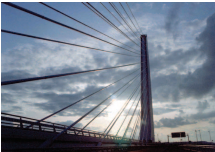
Fig. 18. Puente del Alamillo
