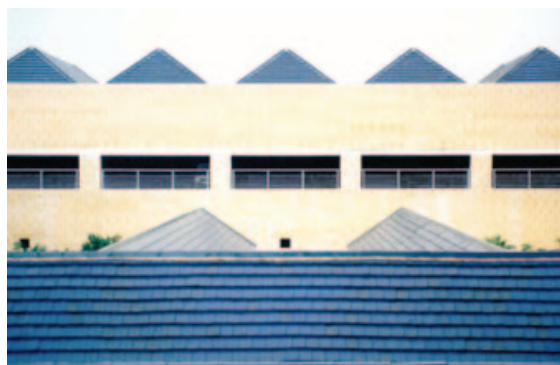
Fig. 16. Vista parcial del aeropuerto de San Pablo
