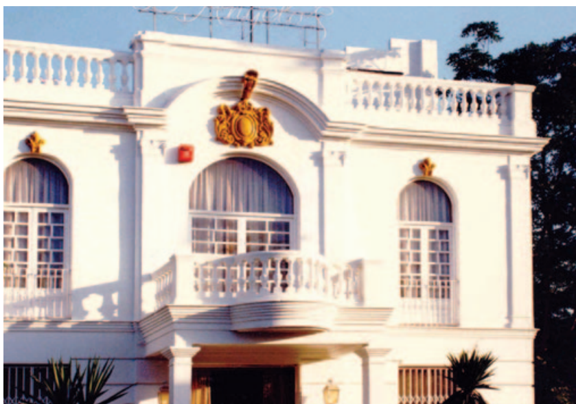
Fig. 10. Chalet en la avenida Manuel Siurot
