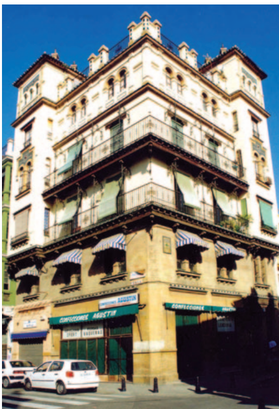
Fig. 13. Edificio de José Espiáu en la calle Feria esquina Cruz Verde
