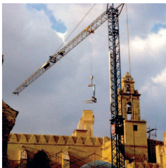
Fig. 20. Rehabilitación de la Cartuja
