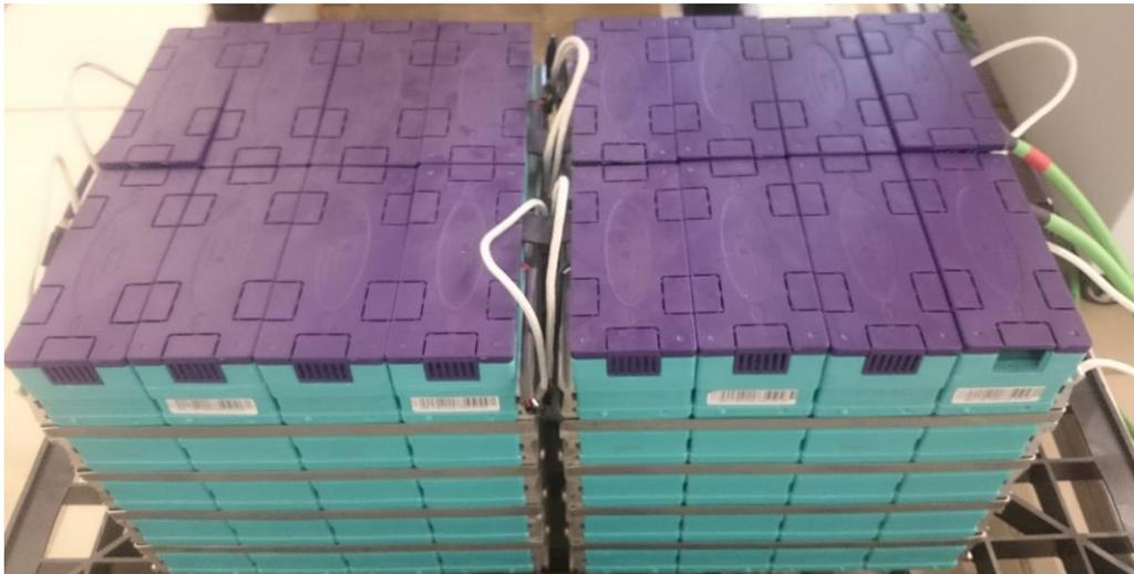
Figura 3.1. Bloque de baterías de Ion-Litio instaladas en la microrred.
