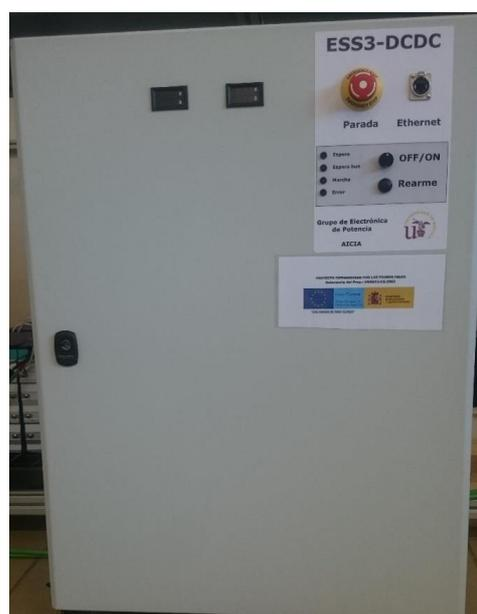
Figura 3.2. Convertidor DC/DC instalado en la microrred.
