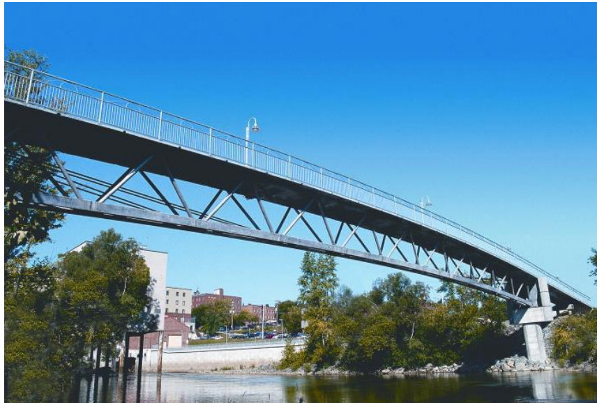
Figura 1-1. Pasarela peatonal, Sherbrooke, Quebec, Canadá [3]
