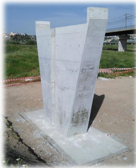
Figura 3-13: Pila de la rampa 1 de la pasarela de Tablada. Fuente: Diario de Sevilla.
