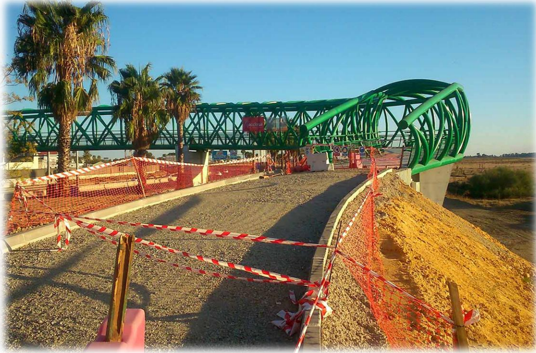
Figura 3-8: Terraplén de acceso a la pasarela desde San Juan de Aznalfarache. Fuente: MRN Magazine.
