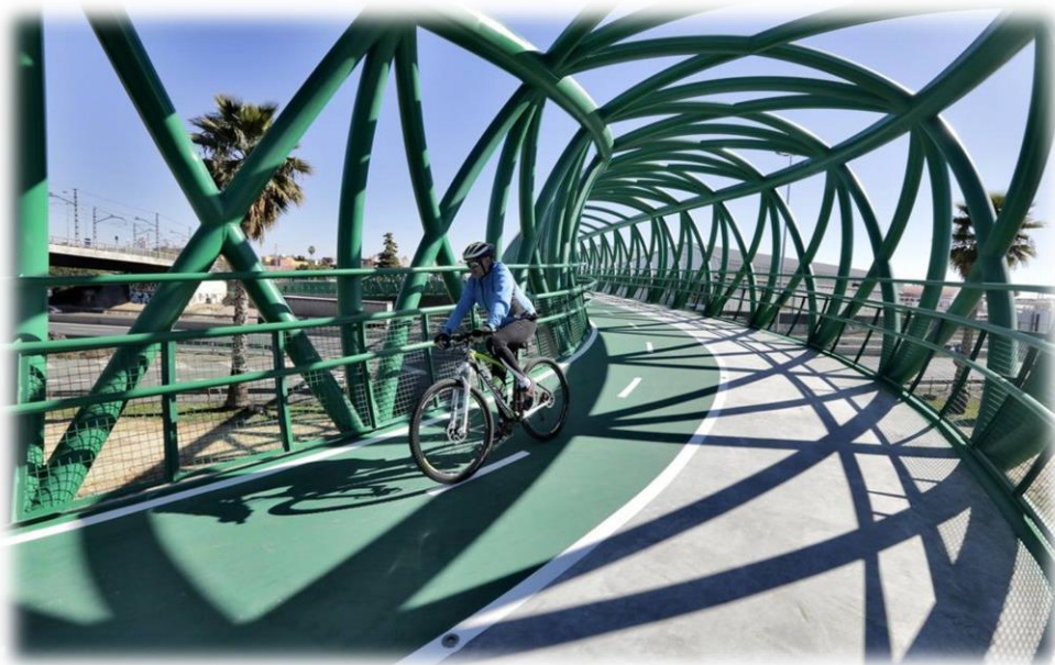
Figura 3-3: Vista interior de la pasarela de Tablada sobre la SE-30. Fuente: Red de Ciudades por la Bicicleta.
