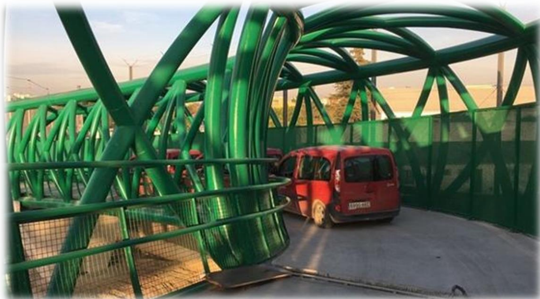
Figura 3-7: Detalle de la barandilla de seguridad y de la valla antivandalismo de la rampa 2. Fuente: ABC de Sevilla.
