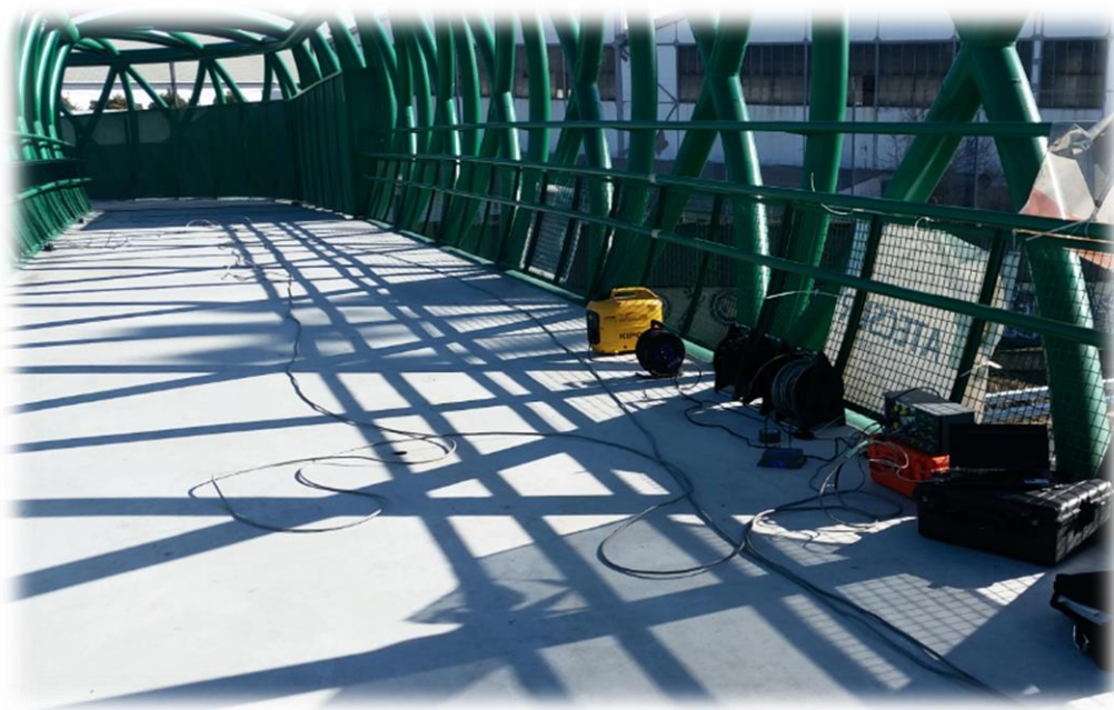
Figura 3-18: Montaje de equipos y desarrollo del ensayo de vibración ambiental.
