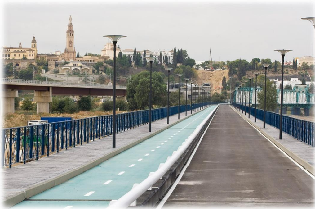
Figura 3-2: Conexión del carril bici de la pasarela de Tablada con el Puente de Hierro. Fuente: Agencia de Obra Pública de la Junta de Andalucía.
