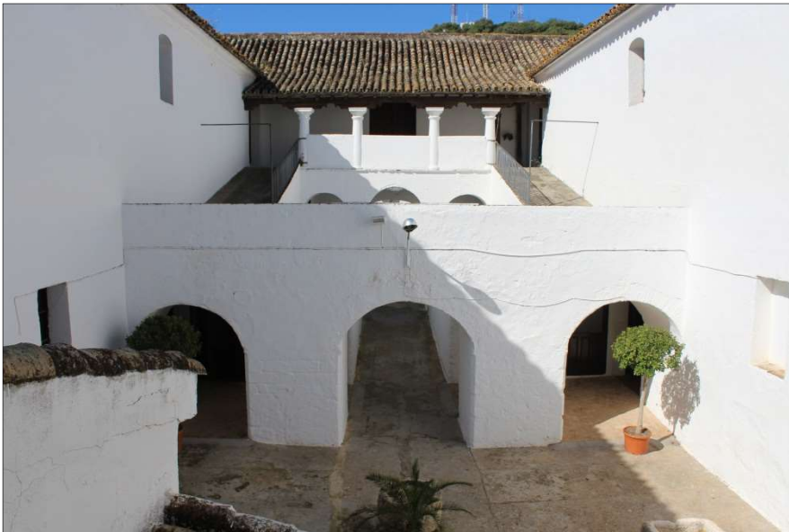
Fig. 4: Pórtico patio interior con rampas de acceso. Foto propia
