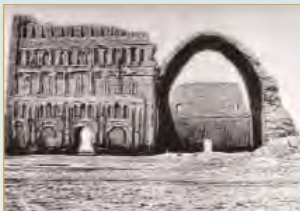
Fig. 1: Bóveda de directriz próxima a la Parábola; Palacio de Ctesifonte 241-272 dC., Siria periodo Sasánida.
