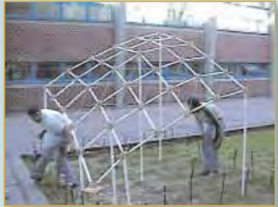
Fig. 4: Alumnos armando una maqueta escala 1:5 de una cubierta de nodos y barras con geometría de catenaroide-elíptico.
