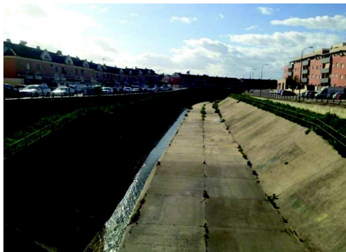
Figura 10. Canalización del tramo de desembocadura del arroyo.
