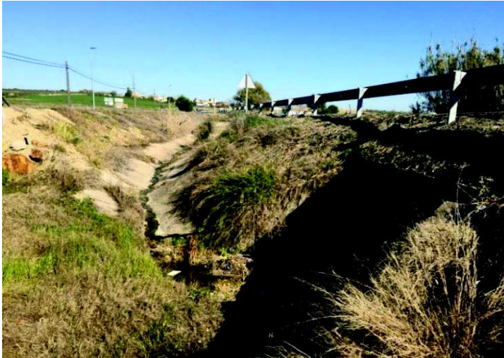
Figura 7. Entrada al arroyo Riopudio del drenaje de la cuneta de la carretera a Salteras.
