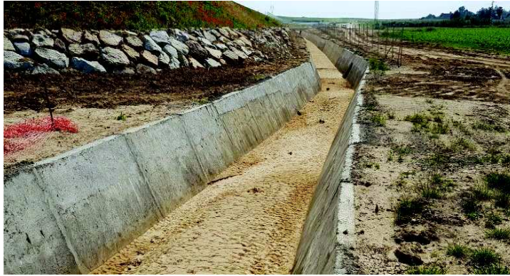
Figura 11. Implantación de cunetas hormigonadas en la futura SE-40, en su trazado paralelo al Riopudio.
