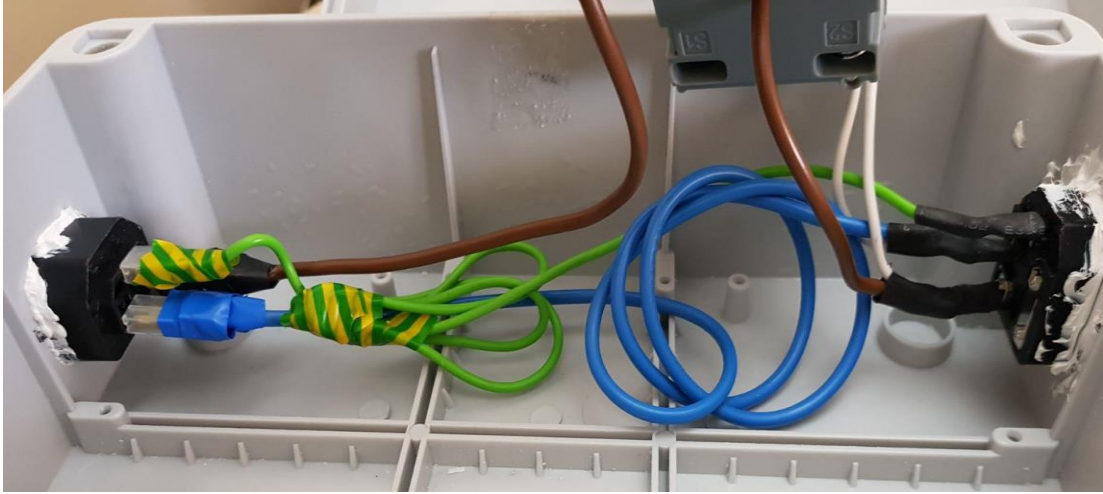
Ilustración 12: Implementación de conectores y cableado
