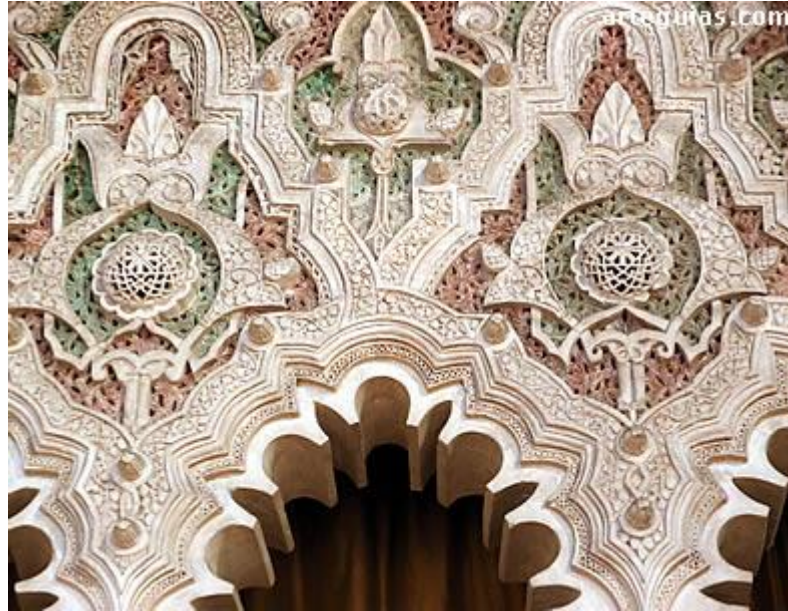
figura 8. Fotografía de detalles de la yesería policromadas de la sinagoga del Tránsito (url: en webgrafía)
