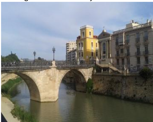
Fotografía 1. Puente viejo sobre el río.
