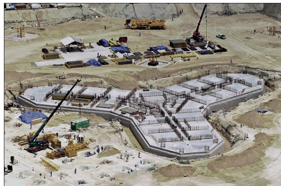
Ilustración 43_Foto cimentación edificio Burj Khalifa, extraída de internet
