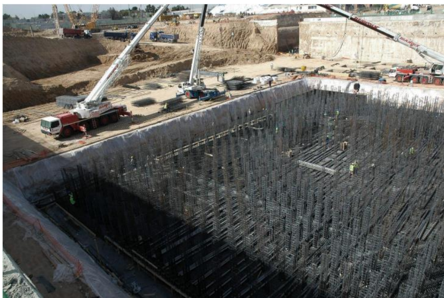
Ilustración 37_Foto ejecución losa de cimentación Torre Caja Madrid, extraída de internet
