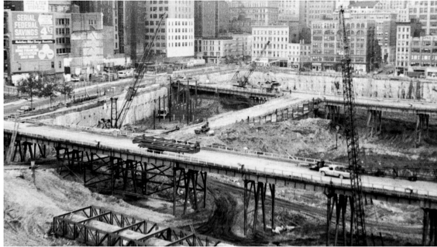
Ilustración 30_Foto de la excavación de la cimentación de las Torres Gemelas, extraída de internet
