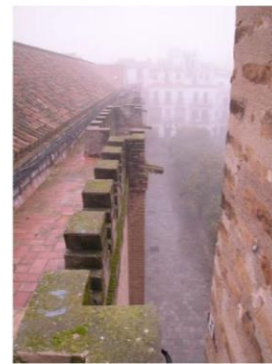
Ilustración 15: Recrecido del adarve en cubierta con la subida de la cubierta para alojar la maquinaria de A/A. Ilustración 58 [22]
