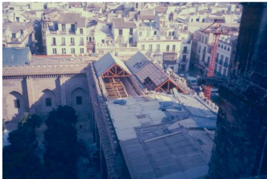
Ilustración 14: Remodelación de las cubiertas de la Biblioteca 1988. Ilustración 71 [22]
