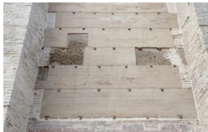
Ilustración 9: Detalle fachada nave Norte Ilustración 126 [22]
