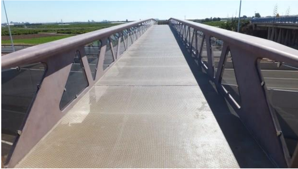
FIGURA 5. Pasarela sobre la V-21 en Puçol. Fuente: Google.
