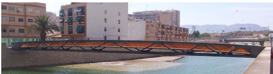
FIGURA 4. Pasarela de UHPFRC sobre el Barranco de las Ovejas (Alicante). Fuente: Google.
