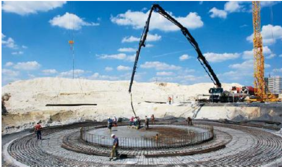
Figura 5-7. Ejecución de la cimentación de uno de los aerogeneradores
