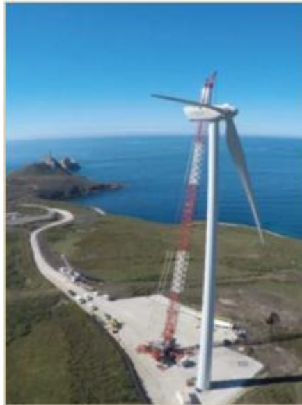
Figura 3–5. Montaje aerogenerador en Cabo Vilano (agosto de 2016)
