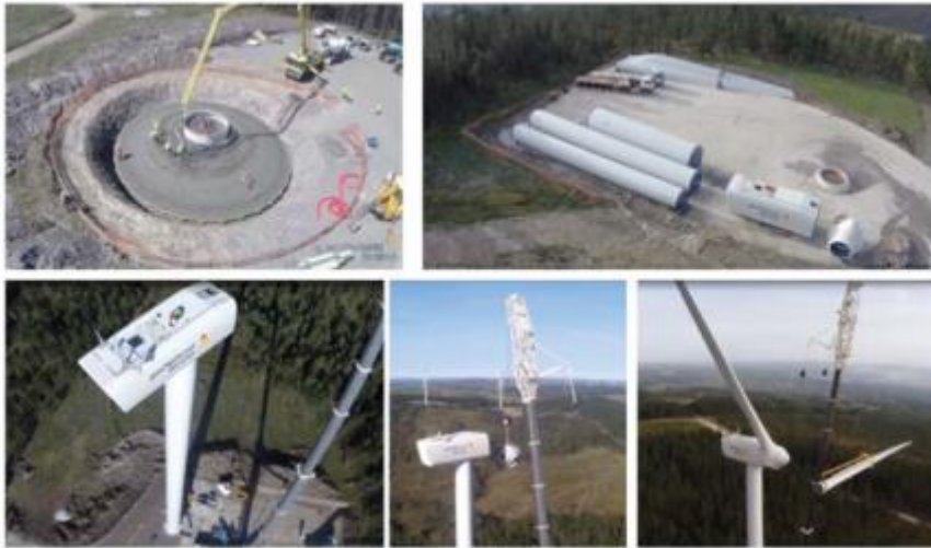
Figura 3–4. Imágenes de secuencia de instalación de nuevas máquinas en Cabo Vilano
