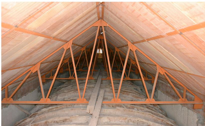
**Fig. 3.** Estructura moderna que soporta el tejado que cubre el trasdós de la bóveda de cañón y que vino a sustituir a la antigua que repararon Santiago de la Llosa y Pedro Osuna.
