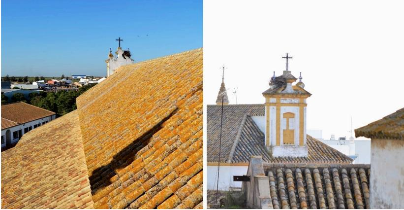
**Fig. 4.** Izquierda: Cubiertas modernas de la nave principal, nave de la epístola y capillas colaterales a excepción de la del Sagrario. Derecha: Buhardilla para aireamiento de la antigua armadura y trasdós del cañón.
