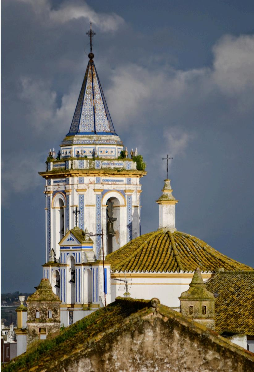
**Fig. 8. El cuerpo de campanas, así como la cubierta de la bóveda de la capilla mayor y su remate proceden de las intervenciones realizadas entre 1802 y 1834. La decoración, la estructura del chapitel y la espadaña son obras posteriores.**
