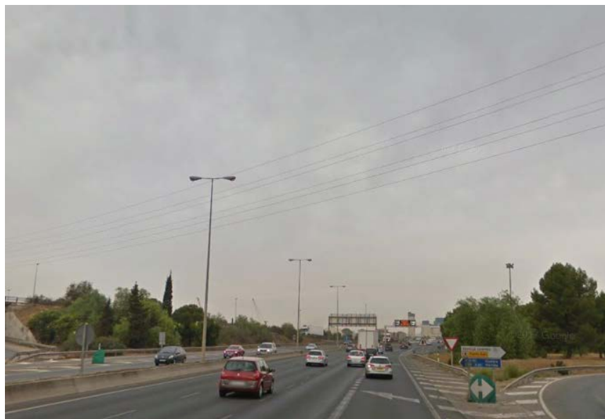
Ilustración 3-11 Tramo de la SE-30 antes del puente
