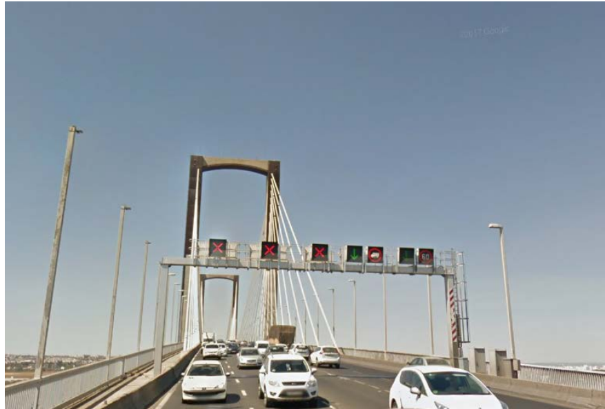
Ilustración 3-10 Tramo de la SE-30 sobre el puente del V Centenario
