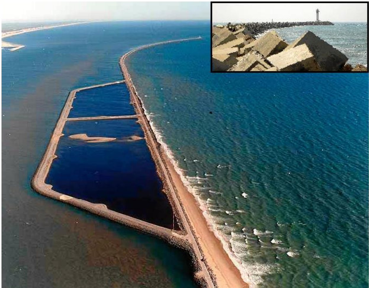
Figura 4: Vista del Dique Juan Carlos I. Puerto de Huelva. Fuente: (Huelva Buenas Noticias, 2018)
