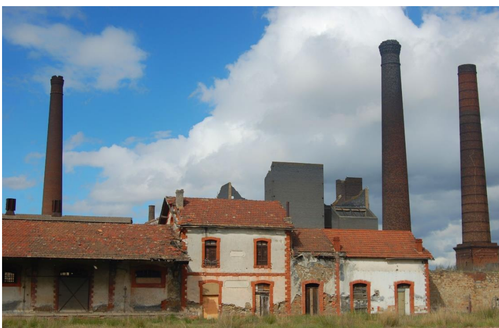
Ilustración 17. Antigua estación de ferrocarril del Cerco Industrial de Peñarroya-Pueblonuevo (Córdoba, España). Abril 2016. Autor: Pietro Viscomi.
