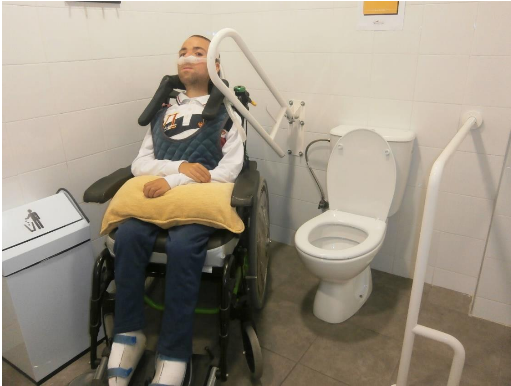
Pie de Foto. Foto Realizada por Consuelo Vizcaíno Terrero. Imposibilidad de realizar una transferencia lateral al inodoro para una persona con movilidad reducida debido al reducido espacio existente.
