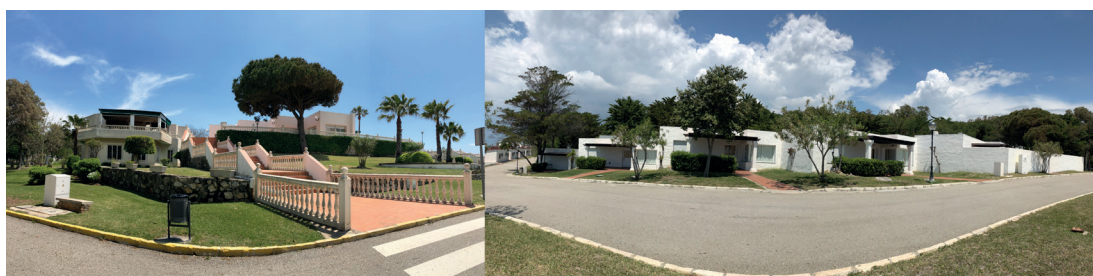
Figura 12. Izquierda: Edificio de usos recreativos varios junto al comedor. Derecha: Cinco viviendas para personas con movilidad reducida (2018).
