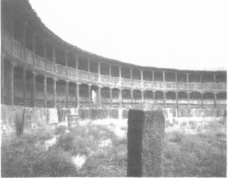
Fig. n.º XIV.21.— Plaza de toros de la ciudad de Toro (Zamora) (Fot. de F. Tuduri en ____: Plazas de Toros de Castilla y León , Valladolid, Consejería de Educación y Ciencia, Junta de Castilla-León, 1998, pág. 200). Inaugurada en 1825 el elemento constructivo dominante es la madera. A pesar de su interés etnográfico y su belleza formal se encuentra fuera de uso y en lamentable estado de abandono.
