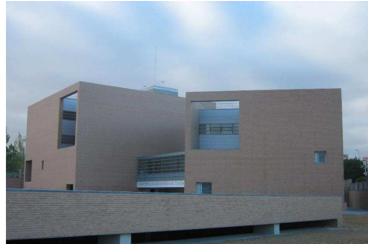
Fig. 15 Confederación Hidrográfica del Guadiana
