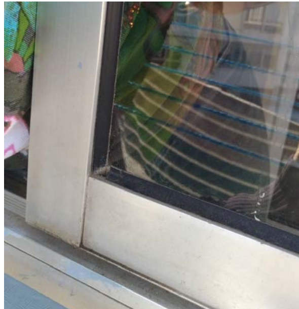
Img 43. Carpintería existente. Ed: Elaboración Propia.
