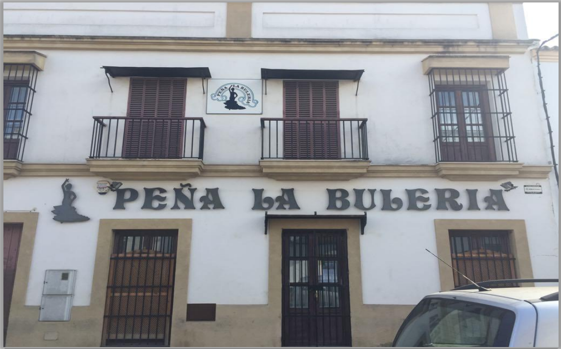
Edificio de la Peña de la Bulería en el barrio de la Plazuela
