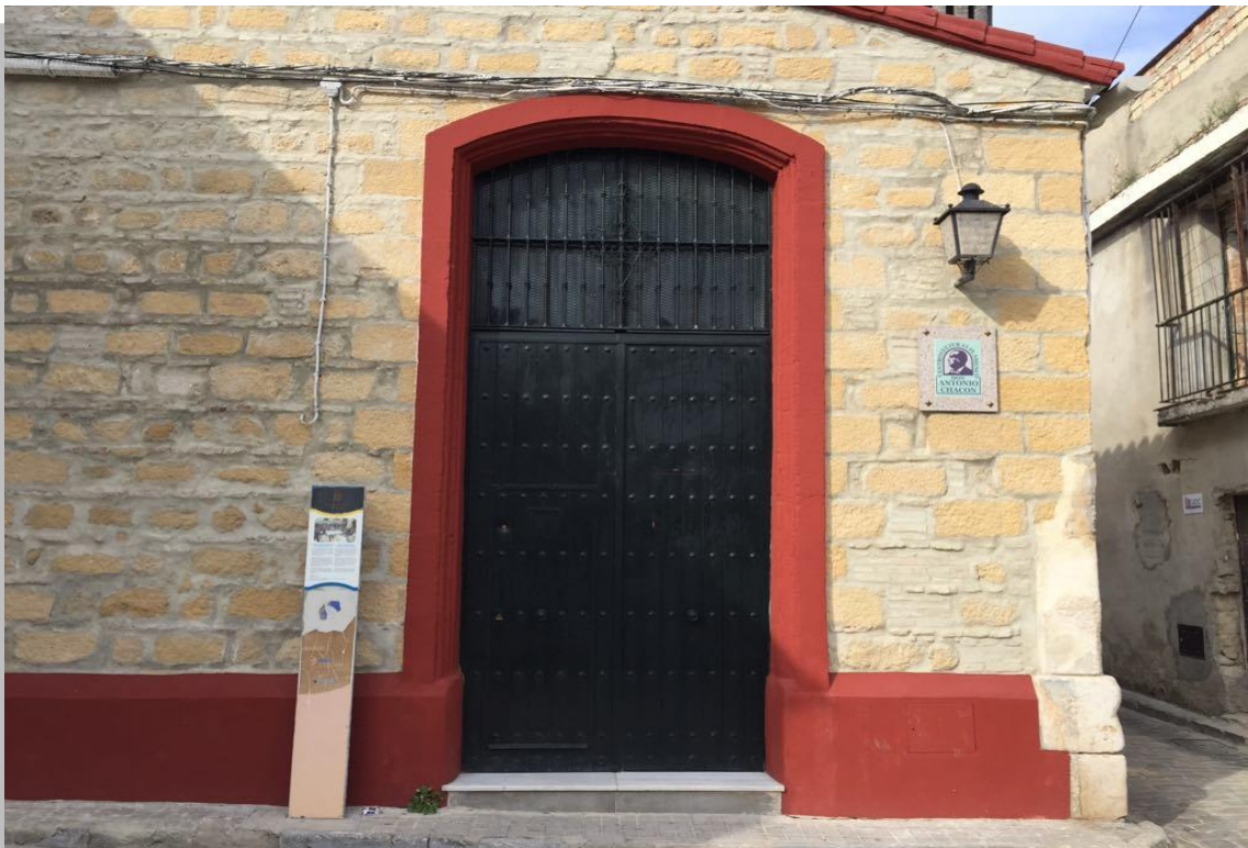
Edificio del Centro Cultural Flamenco Don Antonio Chacón, entre los barrios de Santiago y San Miguel
