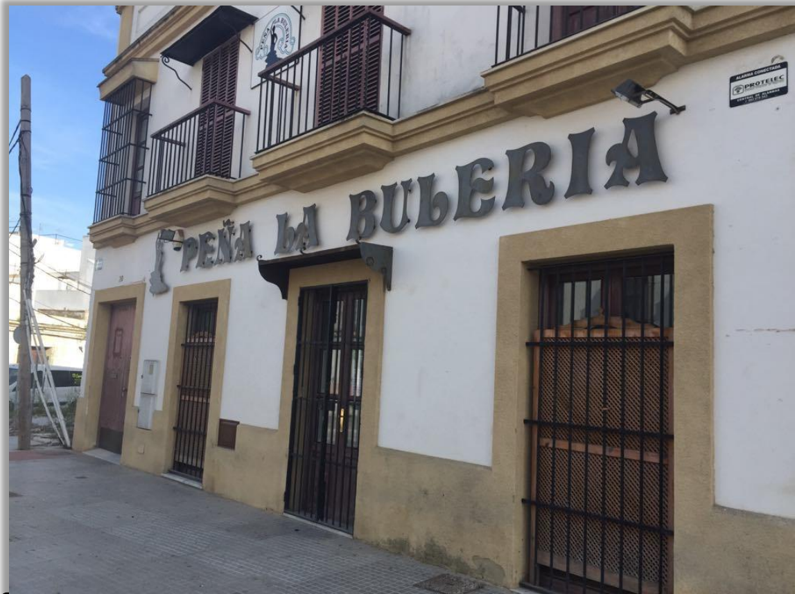
Edificio de la Peña de la Bulería en el barrio de la Plazuela
