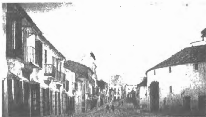
Fig. nº 43.- La calle de San Carlos en el Siglo XIX; a la derecha la Plaza de Toros de Ronda. (Garrido, 1985: 35).
