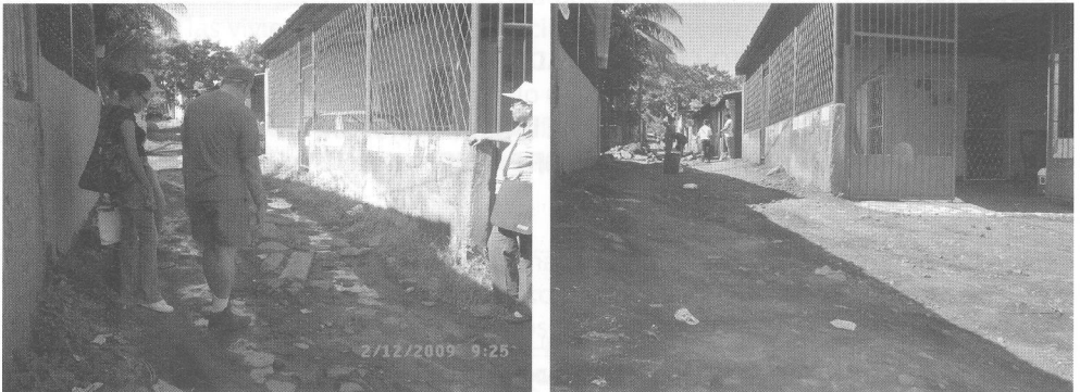
Situación de la calle Olof Palme, tramo del canal depurador (antes/después de la intervención)
