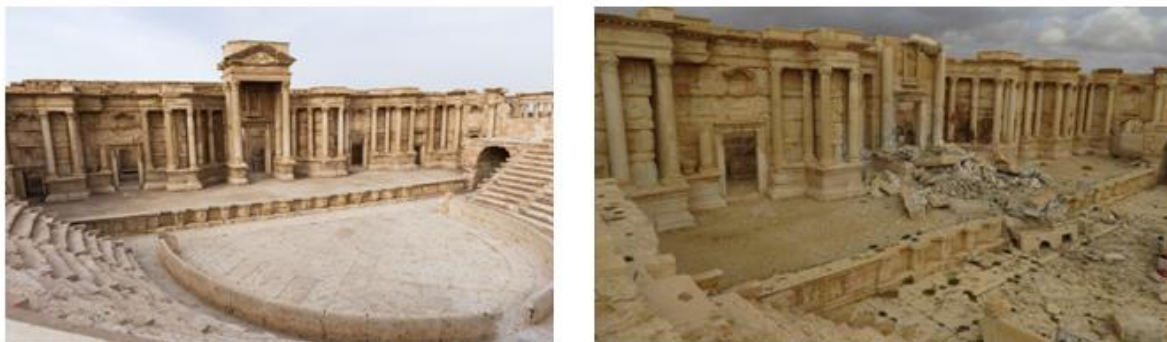
Figura 3.6. Daños sobre el teatro romano tras ataques en enero de 2017
