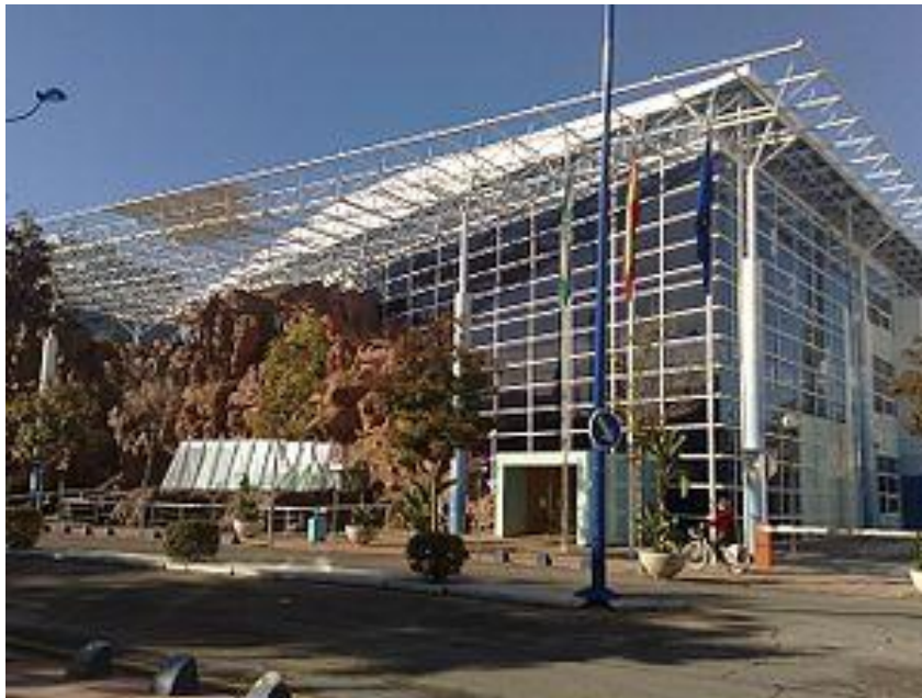
Fig.1 Fachada del edificio del IECA en el antiguo pabellón de Nueva Zelanda en la Isla de la Cartuja (Sevilla)
