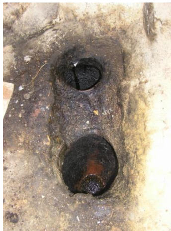
Foto 12. Pozos de decantación
