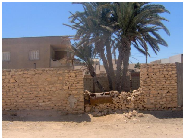
Foto 14. Vista desde el exterior del molino de Aïchoucha
