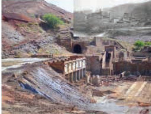
Figura 6. Restos de las antiguas instalaciones de las Zarandas
