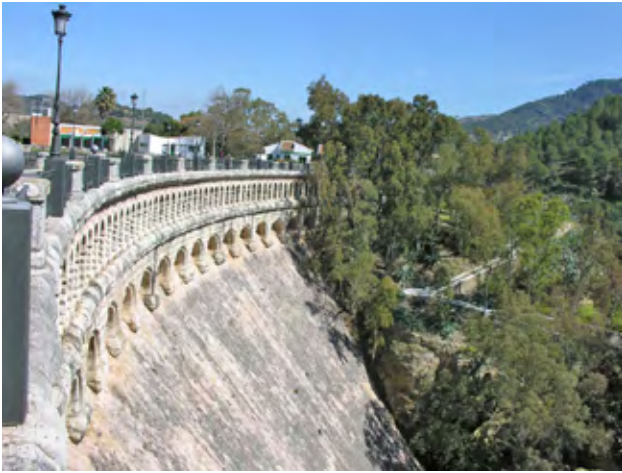
Conjunto hidroeléctrico El Chorro en Ardales (Werner Martínez del Campo, Benjumea Burín, Molina, 1908-1944)
