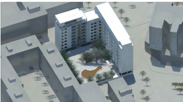
Figura 5.- Propuesta 1. Arriba estado actual del edificio, abajo reformado. La característica es el remonte sobre cubierta. Aparcamiento en superficie bajo nueva cubierta. Autores: Pablo Castro Blanco, Rafael Fernández Galindo y Mohamed Yassine Amazouz Ait Aissa.
