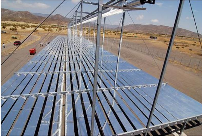
Ilustración 17-Colector de demostración lineal MAN instalado en la PSA
