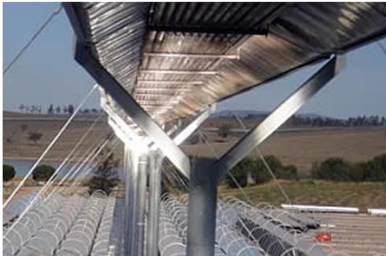
Ilustración 8-Receptor de la planta Kimberlina [12].
