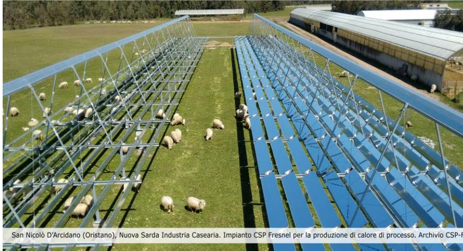
Ilustración 22-Colectores Fresnel de Nouva Sarda [28]
