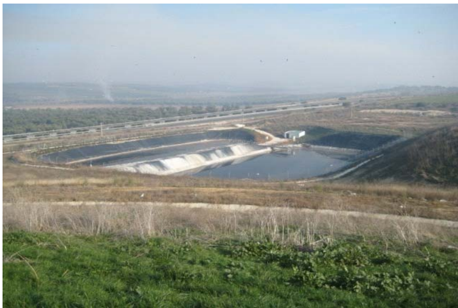
Balsa de Lixiviados. Líquido resultante de la descomposición de materia orgánica y por el agua lluvia percolada a través de los residuos
