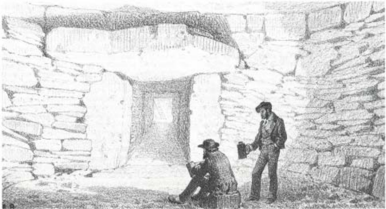
Vista de la Galería tomada desde la Cámara Circular.
