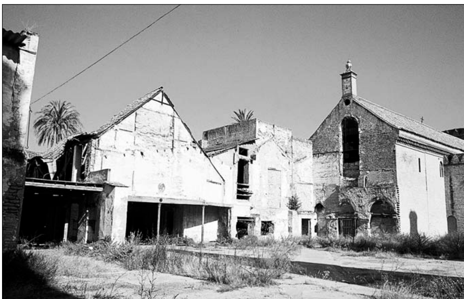
14. Extremo del Refectorio y acceso a Cocinas.
