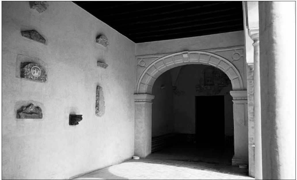
15. Restauración del ámbito de conexión integrando fustes dispersos.
