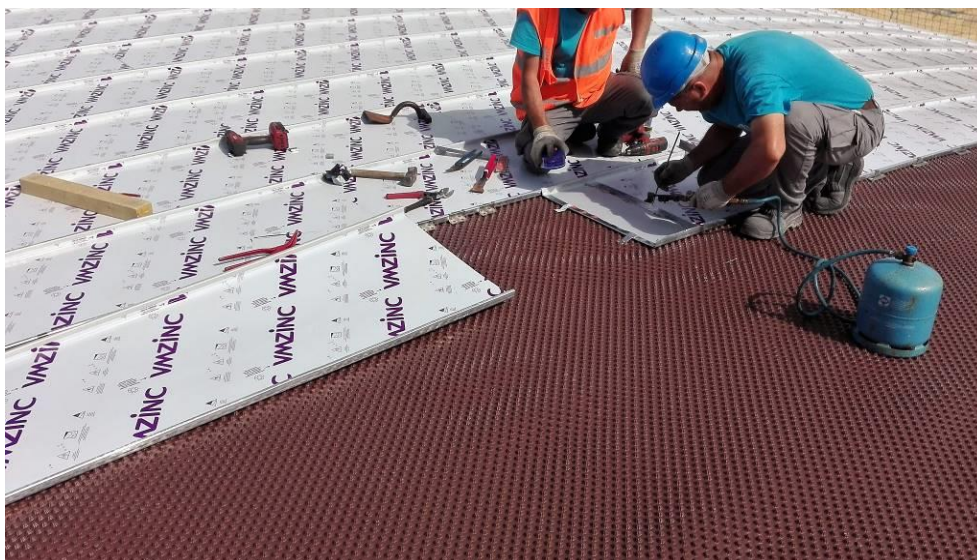
Ilustración 45 - Elaboración 4 de solapes de chapas de zinc. Fuente: Elaboración propia.
