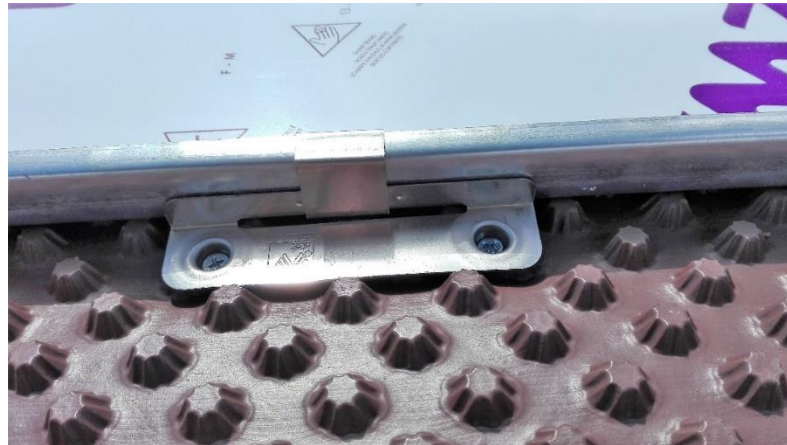
Ilustración 31 - Detalle fotográfico patillas correderas. Fuente: Elaboración propia.
