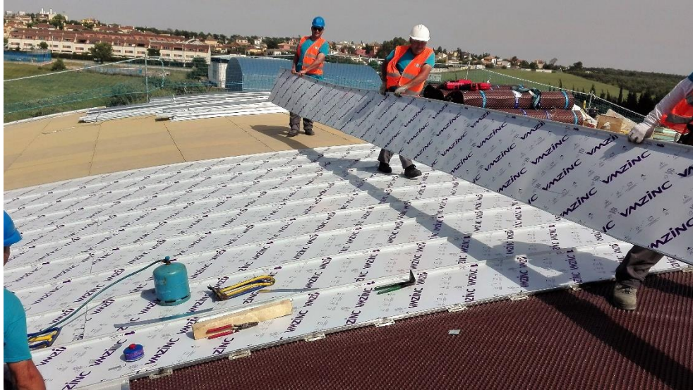
Ilustración 40 - Carga y transporte 2 de chapas de zinc. Fuente: Elaboración propia.
