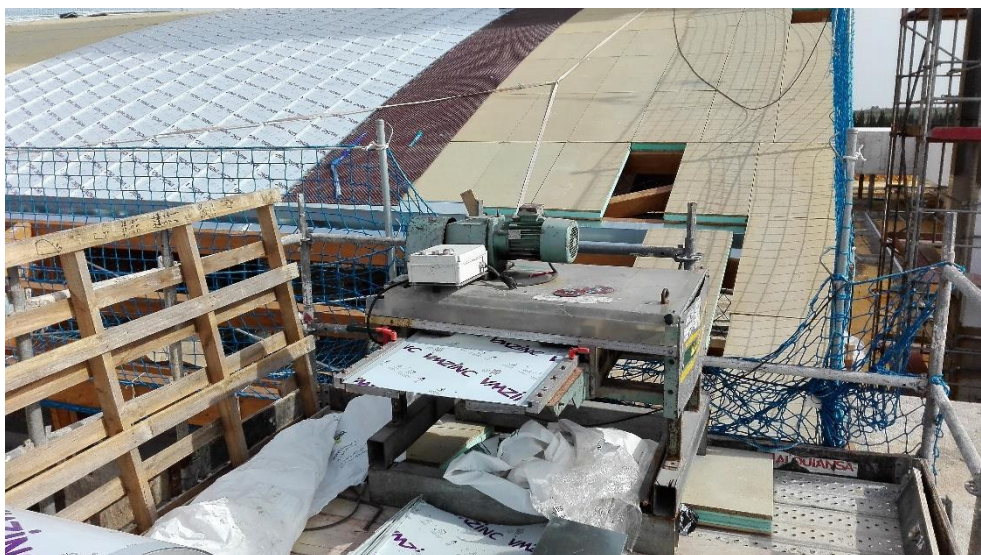
Ilustración 37 – Vista centro de conformación de bobinas de zinc. Fuente: Elaboración propia.
