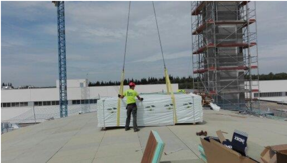
Ilustración 14 – Vista trabajos de descarga de material en cubierta. Capilla CEU Bormujos, Edificio objeto de estudio. Fuente: Elaboración propia.
