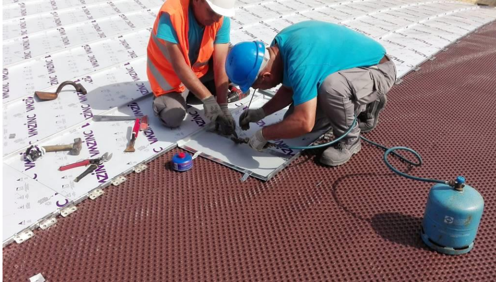
Ilustración 44 - Elaboración 3 de solapes de chapas de zinc. Fuente: Elaboración propia.
