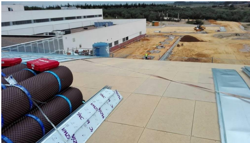
Ilustración 25 - Vista material acopiado en cubierta. Capilla CEU Bormujos, Edificio objeto de estudio. Fuente: Elaboración propia.
