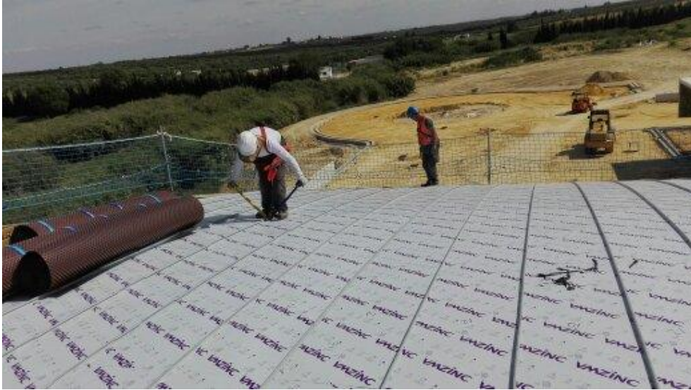
Ilustración 46 – Engatillado manual de chapas de zinc. Fuente: Elaboración propia.
