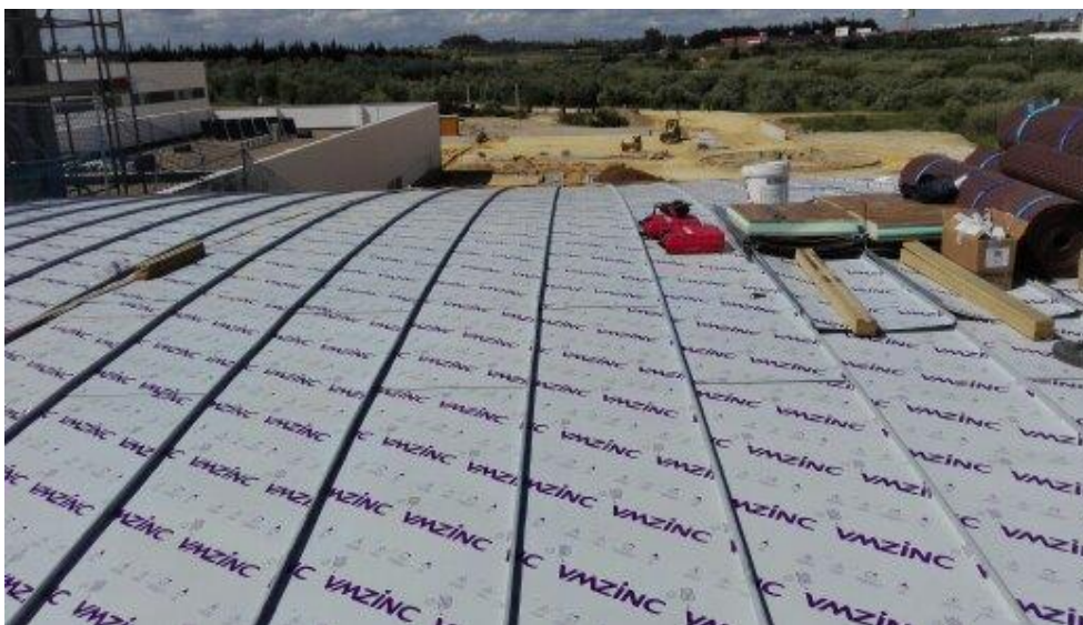
Ilustración 36 - Vista chapas de zinc ya ejecutadas a falta de eliminación de film protector. Fuente: Elaboración propia.
