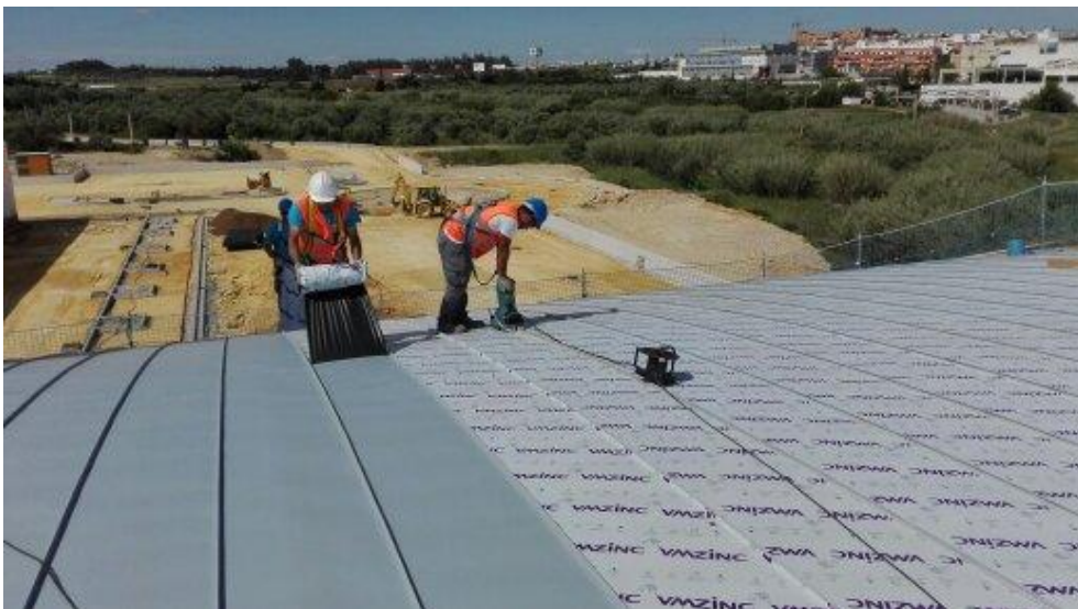
Ilustración 47 – Eliminación de film protector de chapas de zinc. Fuente: Elaboración propia.
