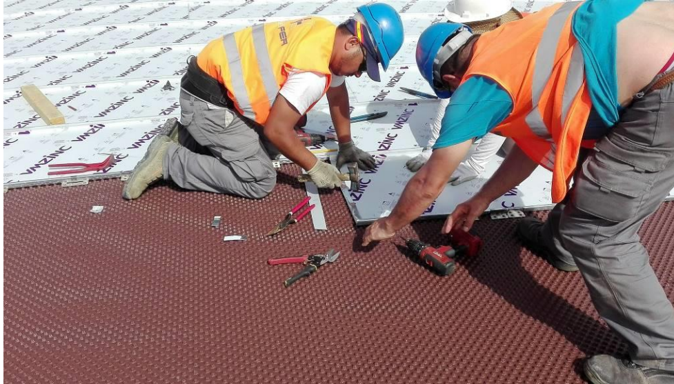
Ilustración 42 – Elaboración de solapes de chapas de zinc. Fuente: Elaboración propia.
