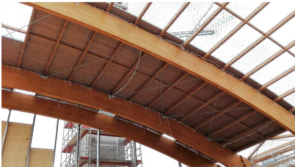
Ilustración 21 - Vista paneles encajados tras varias m2 ya ejecutados. Capilla CEU Bormujos, Edificio objeto de estudio. Fuente: Elaboración propia.
