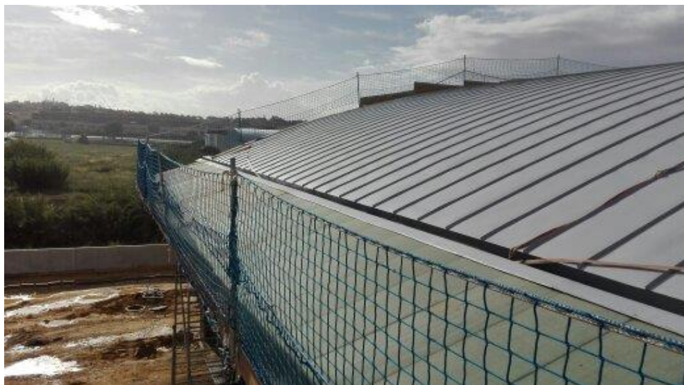
Ilustración 35 - Vista cubierta de aleación ligera, zinc, terminada. Fuente: Elaboración propia.
