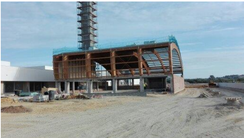
Ilustración 12 – Vista fase de estructuras. Capilla CEU Bormujos, Edificio objeto de estudio. Fuente: Elaboración propia.
