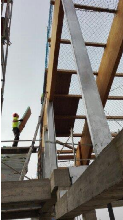
Ilustración 18 - Vista colocación de los primeros paneles en cubierta. Capilla CEU Bormujos, Edificio objeto de estudio. Fuente: Elaboración propia.
