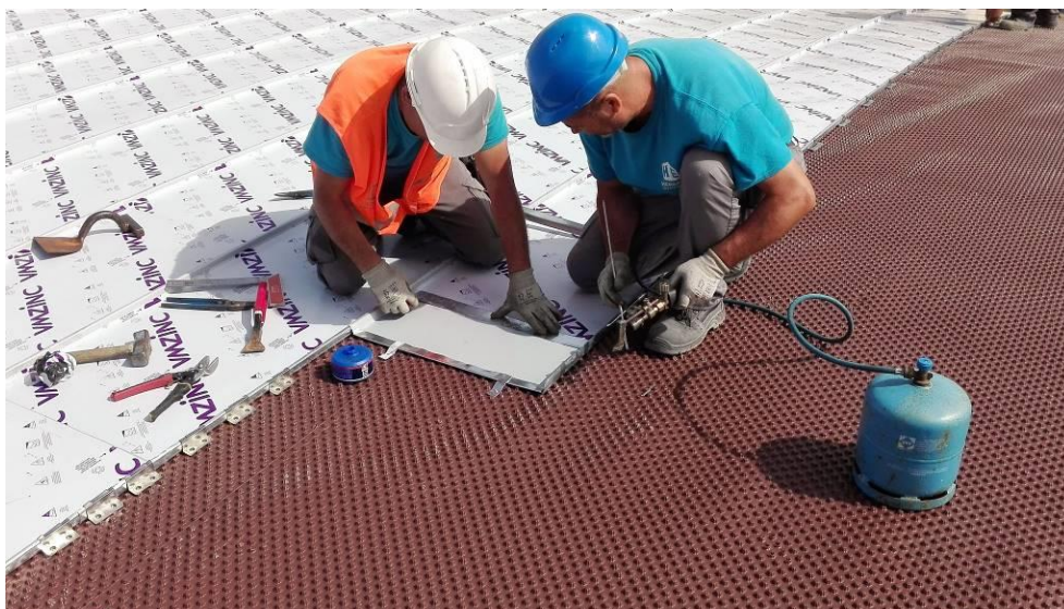
Ilustración 43 – Elaboración 2 de solapes de chapas de zinc. Fuente: Elaboración propia.
