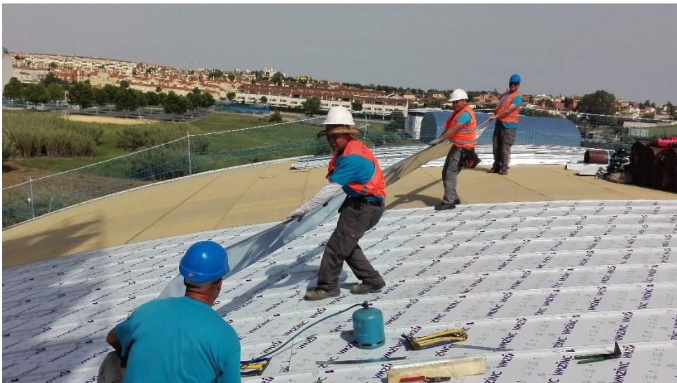
Ilustración 39 – Carga y transporte de chapas de zinc. Fuente: Elaboración propia.
