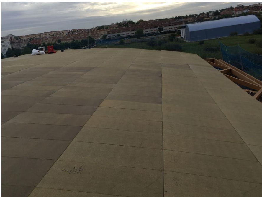
Ilustración 17 - Vista cubrición de cubierta con paneles sándwich terminada. Capilla CEU Bormujos, Edificio objeto de estudio. Fuente: Elaboración propia.
