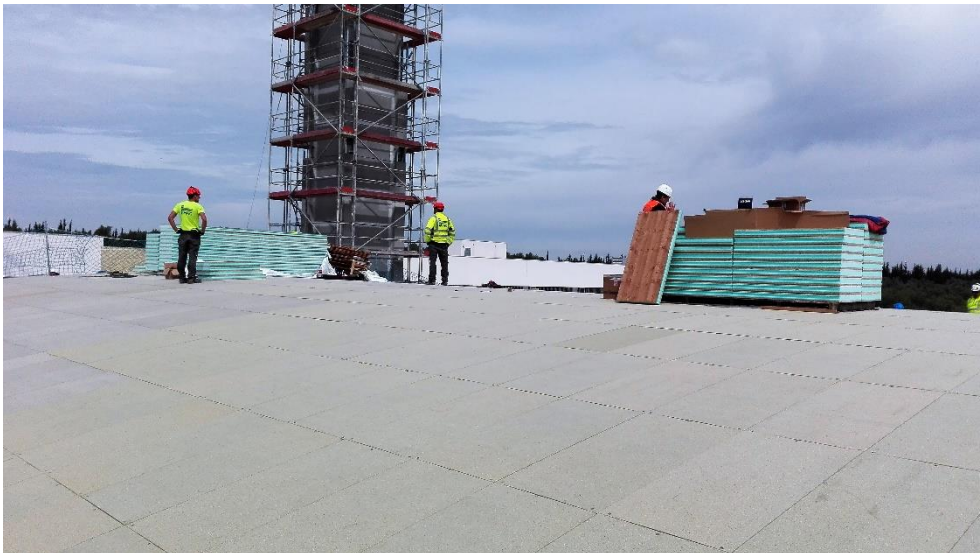
Ilustración 15 – Vista 2 trabajos de descarga de material en cubierta. Capilla CEU Bormujos, Edificio objeto de estudio. Fuente: Elaboración propia.
