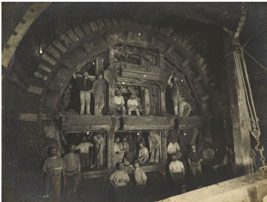
45. Construcción de la línea Central del Metro de Londres, Fotógrafo desconocido, 1898. ((Ilust. Metro de Londres) © Imagen de su autor)
