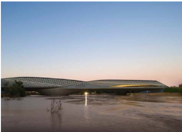
101. Z. Hadid, Pabellón Puente Expo del Agua 2008, Zaragoza, 2008 ((Ilust. Hadid_Pabellón Puente) Hadid, Zaha. © Imagen Fernando Guerra)
