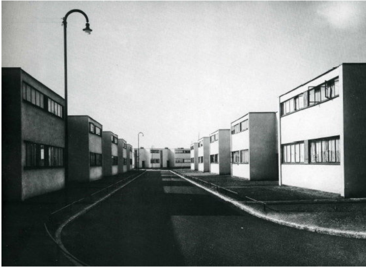
85. W. Gropius, Colonia Töerten, Heidestraße, Dessau, 1926-1928. ((Ilust. Gropius_edificio Konsum) Gropius, Walter. © Imagen de su autor)
