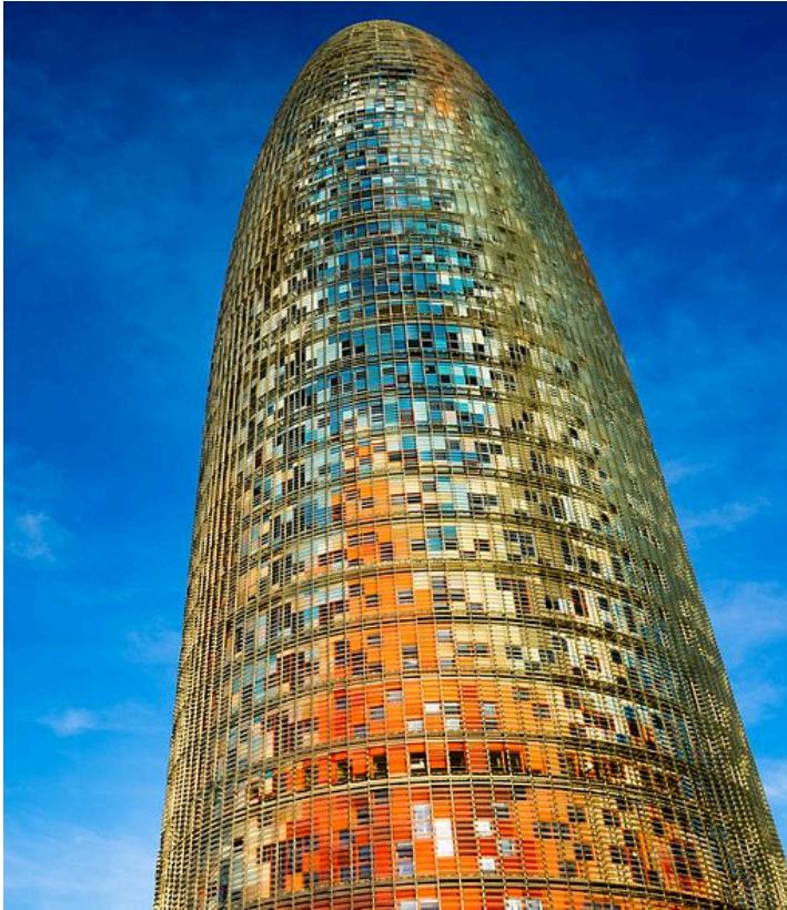
111. . Nouvel y b720, Torre Agbar, Barcelona, 2005. ((Ilust. Nouvel_Torre Agbar) Nouvel, Jean y b720. © Imagen: Bjørn Erik Pedersen (CC BY-SA 4.0) )
