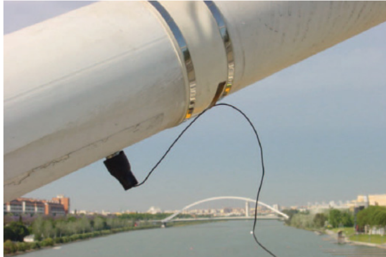
Figura 4.1. Acelerómetro en un cable del Puente del Alamillo. (Casas & Aparicio, 2009)
