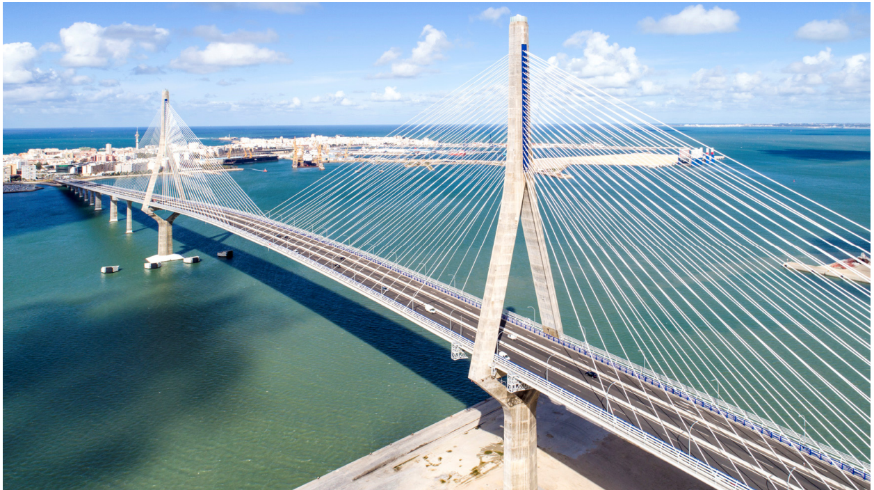
Figura 4.5. Puente de la Constitución de 1812. (CFCSL, 2015)
