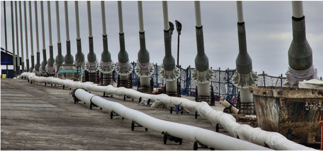
Figura 4.6. Amortiguadores durante el proceso de construcción. (Sanchez, Trotin, & Ladret, 2016)
