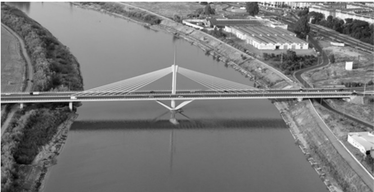
Figura 4.4. Puente de Andalucía (Córdoba). (PuenteMania, 2011)
