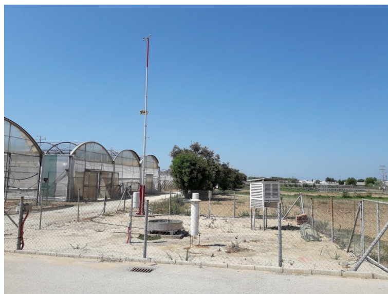
Figura 7. Estación meteorológica del centro IFAPA Chipiona.
