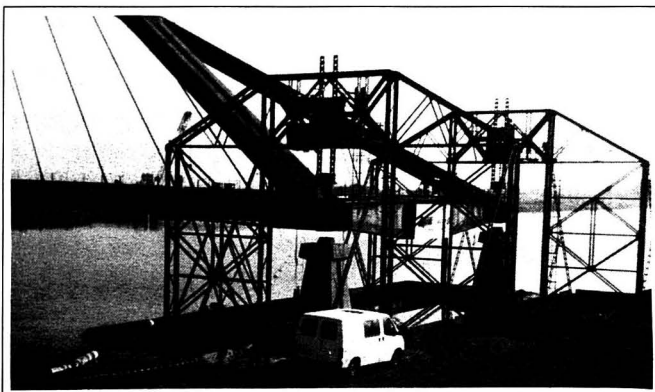
Figura 16 El puente sobre sus apoyos definitivos
